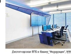
Диспетчерская ВТБ в башне "Федерации", ММДЦ "Сити", Москва. 2011 г.
